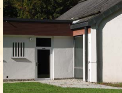
Barrierefreier Zugang zur Kirche über die Sakristei
