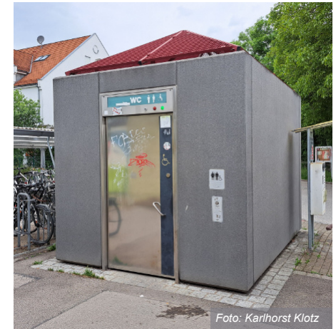
Foto: Karlhorst Klotz
