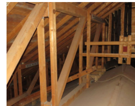
Derzeit wird die Statik des Kirchendachs überprüft
